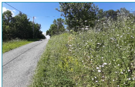
Talus fleuri et berme fauchée
